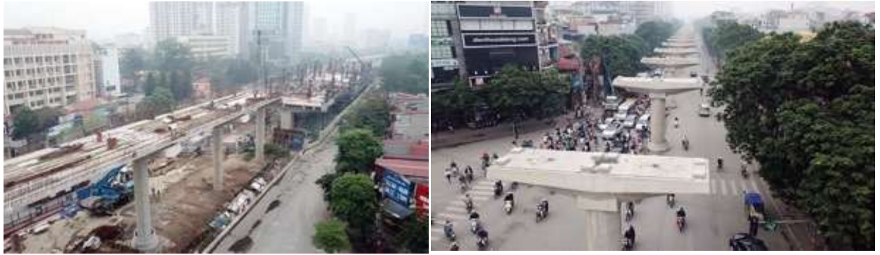
Một số hình ảnh tuyến số 3 Nhổn - Ga Hà Nội đang hoàn thiện
